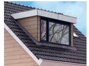
Schleppdachgaube mit Flachdachziegeln bzw. Flachdach
