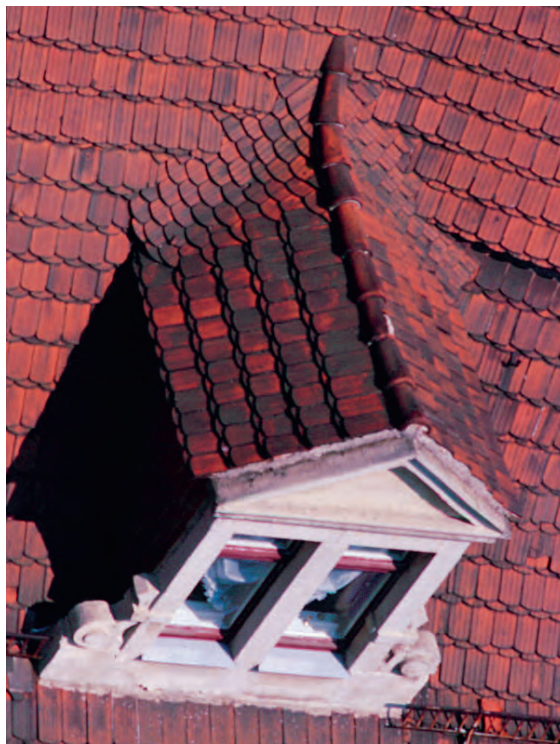
Satteldachgaube mit eingebundener Kehle
