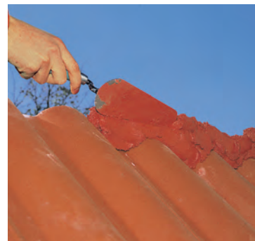
Firstvermörtelung
