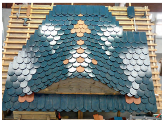
Fledermausgaube, gedeckt (Doppeldeckung)
