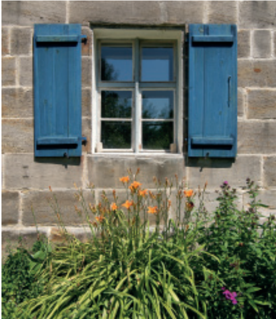
Vorbildlich restauriertes Fenster mit Fensterläden, das mit innen eingefügten neuen Exemplaren zum Kastenfenster aufgedoppelt worden ist. Weiß, Blau und die Farbe des Sandsteins harmonieren perfekt.
