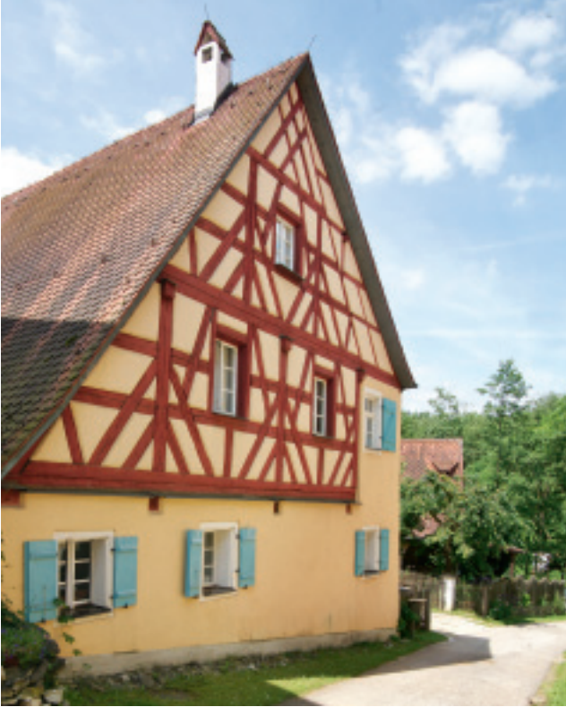
Gelungenes Beispiel für wieder hergestelltes Fassadenbild und angepasstes Farbkonzept: Bauernhaus im Nürnberger Land
