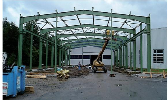
Bild 2 Stahlhalle mit Rahmenträger und Kranlaufbahn
