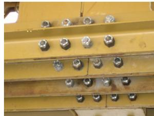
2 Verschraubung an Profilstoß
