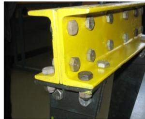
1 Schraubverbindung an Trageinheit
