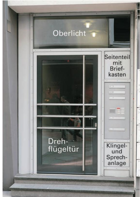
1 Aufbau einer kompletten Hauseingangstüranlage
