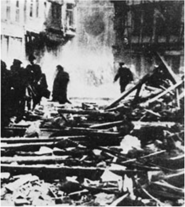
Nr. 3: Eingang Schmiedestraße.
