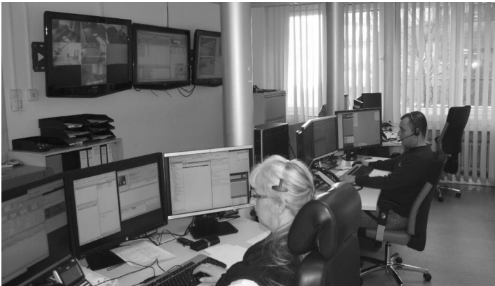
Abbildung 2: Teilansicht einer NSL
