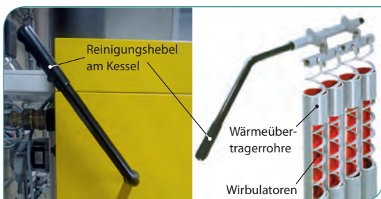
1 Reinigung der Wärmeübertragerrohre
