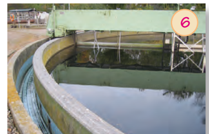
6 Nachklärbecken: Bakterien sinken nach unten. Der Bakterien Schlamm wird abgepumpt und in den Faulturn geleitet, sauberes Wasser fließt in den Fluss.
