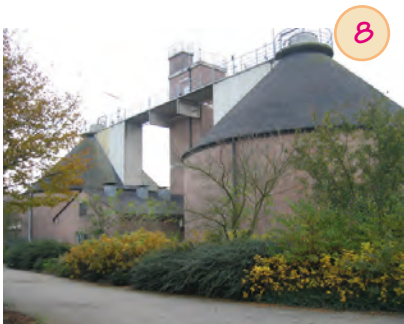
8 Faulturn: Klärschlamm wird eingeleitet. Nach ca. drei Wochen ist Gas entstanden.
