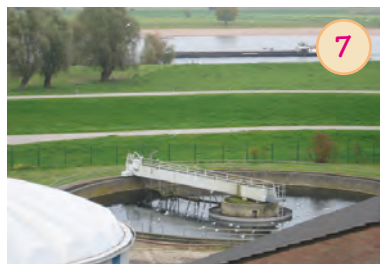
7 Geklärt Wasser: läuft in den Fluss ab.
