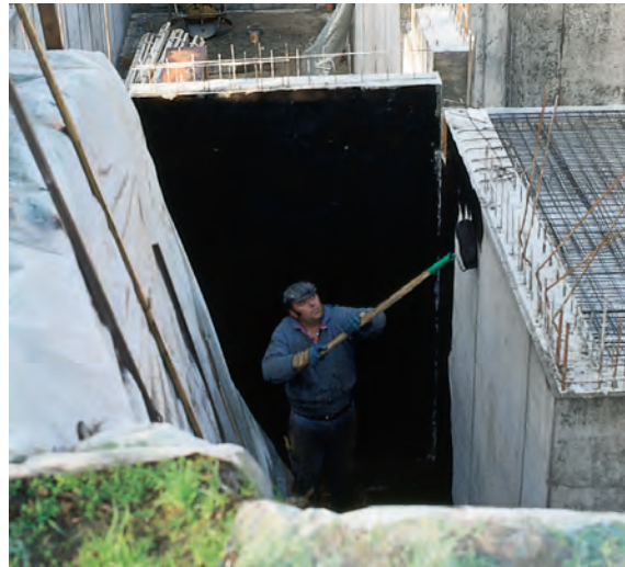
Voranstrich für eine Bitumendickbeschichtung
