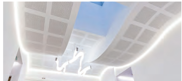
Lichtakzente am Wandanschluss einer geschwungenen Akustikdecke
