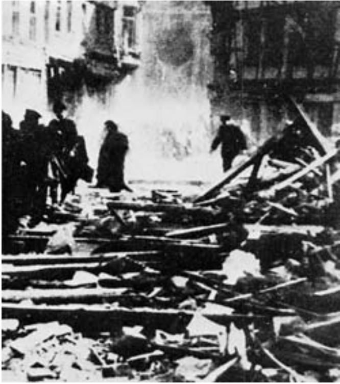
Nr. 3: Eingang Schmiedestraße.
