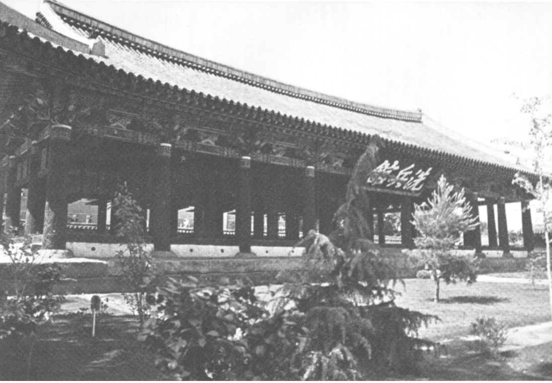
Das alte Schulgebäude in Tong Yong
