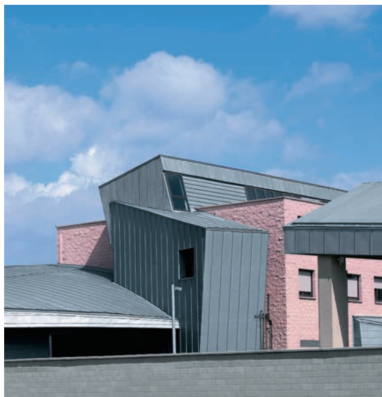
Dach- und Wandeindeckung aus Titanzink
