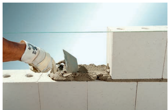
Fugenaufzug mit Normalmauermörtel
