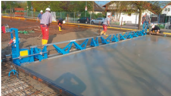
Verarbeitung des Frischbetons auf der Baustelle
