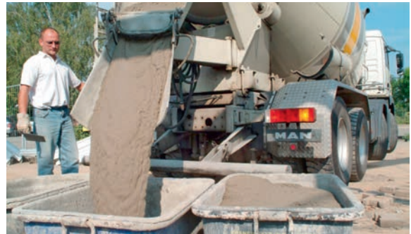
Anlieferung von Werk-Frischmörtel
