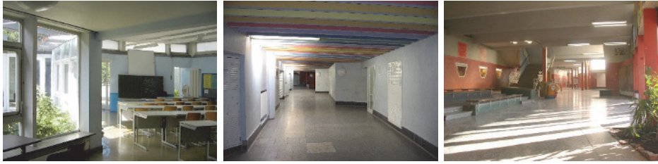
Bild 2-1 Bauzustand 2007, links: Klassenwohnung EG, Mitte: Flur EG, rechts: Pausenhalle (© Spital-Frenking + Schwarz)
