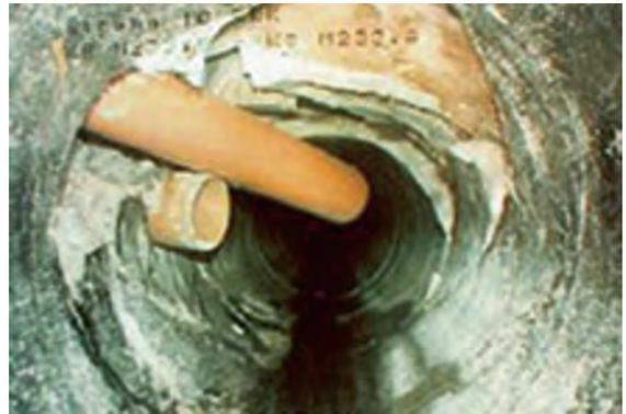
Schaden 2: einzelner fehlerhafter Anschluss
