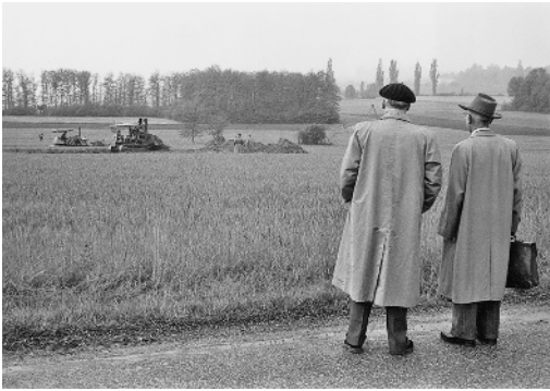
Beginn der CERN-Bauarbeiten am Standort Meyrin (© 1954 CERN, CERN-HI-5405001).
