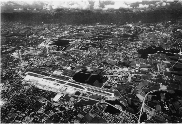
CERN: Luftbildaufnahme, Flughafen Genf, LEP/LHC-Tunnel (© 1986 CERN, LHC-PHO-1986-001).
