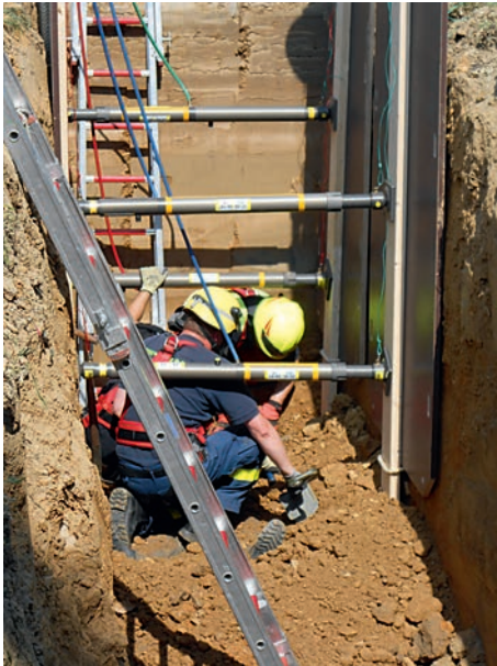
Bild 4: Nach erfolgter Eigensicherung muss zuerst der Brustkorb des Verschütteten freigelegt wer- den. (Foto: Irakli West, Fa. Para- tech)
